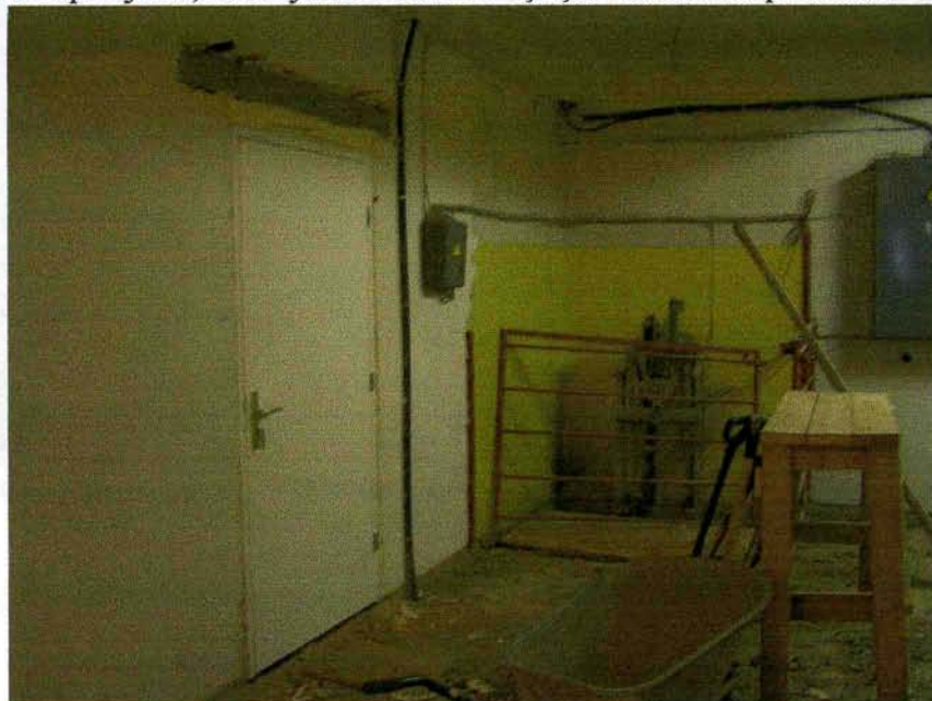
1.attēls Telpa termokameras novietošanai pirms renovācijas
