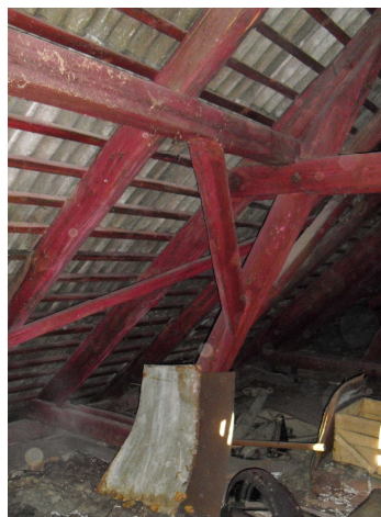
13. Jumta nesošas konstrukcijas.
