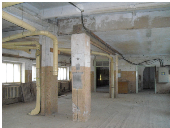
1. Konstruktīva shēma - nepilns karkass.
