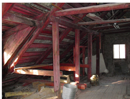
13. Jumta nesošas konstrukcijas.
