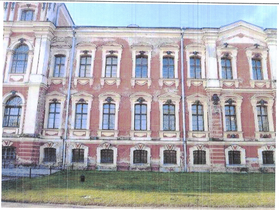
11.att. Austrumu fasāde
