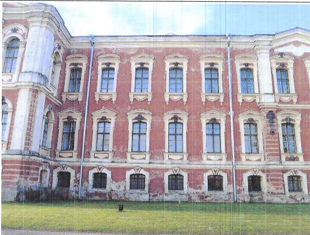
8.att. Austrumu fasāde
