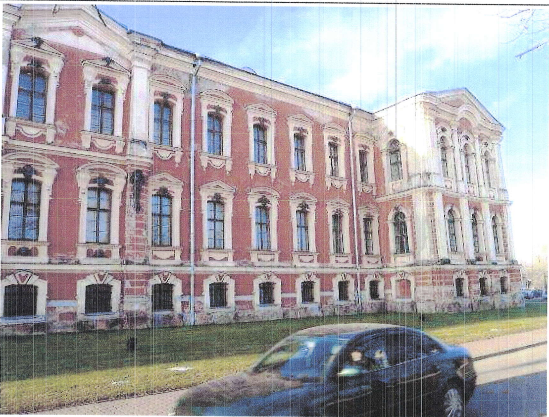
12.att. Austrumu fasāde
